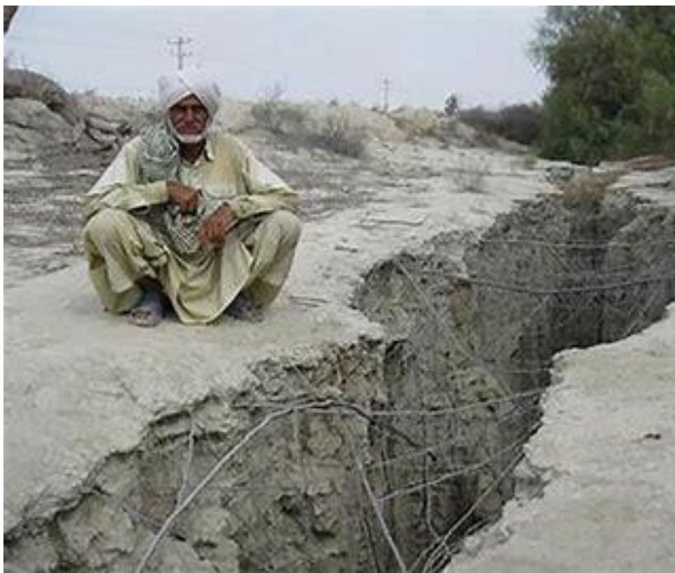
شکل-۷. نمونه‌ای از فرسایش خندقی و ایجاد گالی در منطقه دشتیاری
